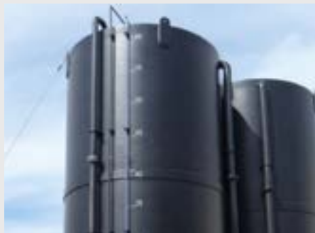
Резервуары для хранения из полиэтилена
