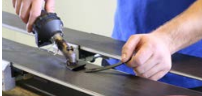
HOT JET S — любимый аппарат для проведения ремонтных работ
