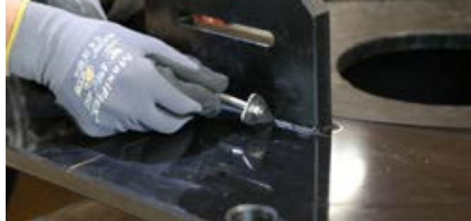
Отличная обработка шва перед сваркой и после сварки
