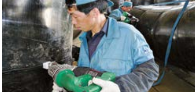
FUSION 2 при сварке резервуара в Китае
