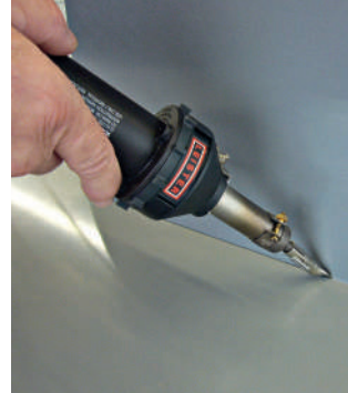
Фиксация свариваемых листов с помощью насадки для прихватки
