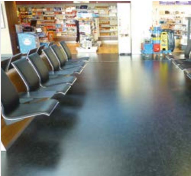
Качественная сварка обеспечивает длительный срок службы покрытия
