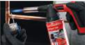
Пайка мягким припоем водопровода и системы отопления
