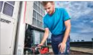
8. Под прямым углом разместите на фитинге пресс-клещи и выполните обжим соединения
