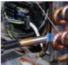
Пайка твёрдым припоем систем кондиционирования и холодильных систем
