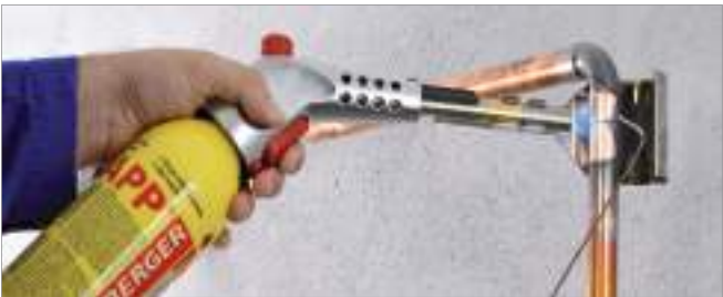
Пайка твёрдым припоем при монтаже системы газоснабжения
