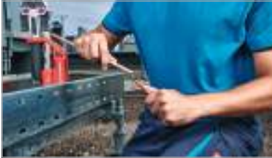
3. Для обработки внутренней части трубы используйте гратосниматель UNIGRAT
