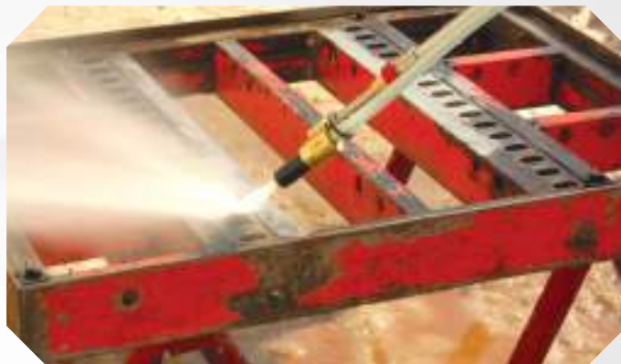
Чистка поверхностей от старой краски
