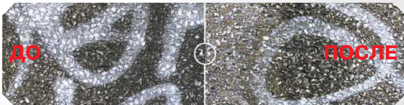
Чистка бетонных поверхностей от граффити
