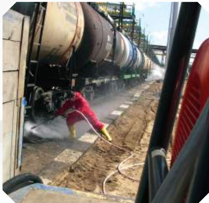
Мойка поверхностей от нефтехимических загрязнений
