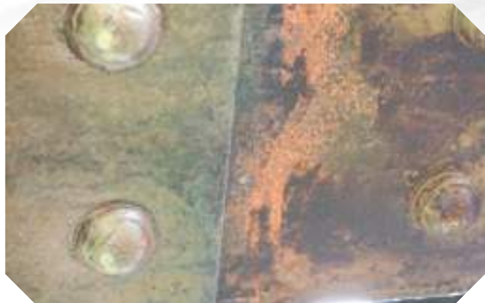
Чистка конструкций из металла
