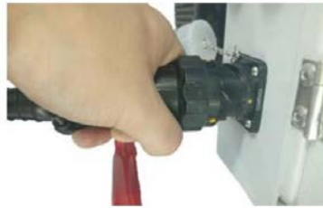
Соединение кабеля с электрической коробкой
